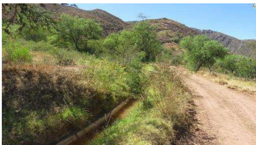
FIGURA N°02: VISTA DE LAS INFRAESTRUCTURAS VIALES Y DE CONDUCCIÓN EN EL SECTOR URALLA II Y SACCSACC, CONSTA DE TROCHA CARROZABLE Y CANAL DE CONCRETO SIMPLE.
